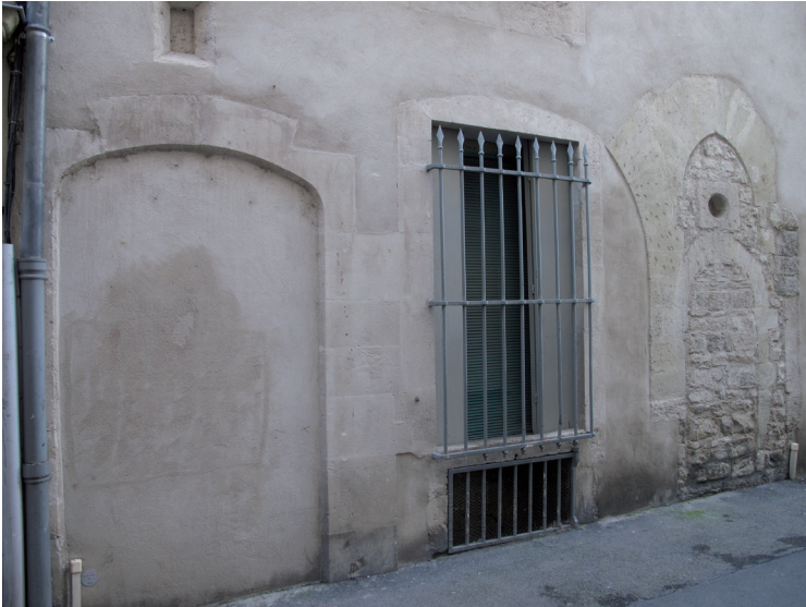
Fig. 4 : Façade. Portes murées
