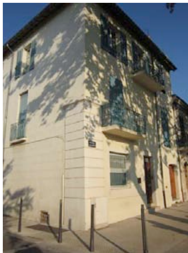
Pilier dit « Mareschal », dans la hauteur du Rez de chaussée.
