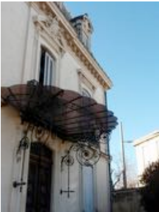
Marquise verre et fer forgé, sur la porte d'entrée. Salamandre.
