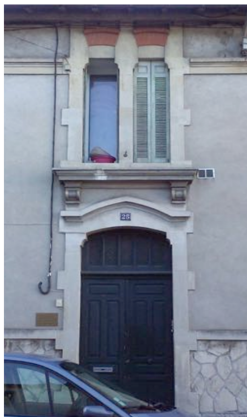
Fenêtre à meneau sur entrée.
