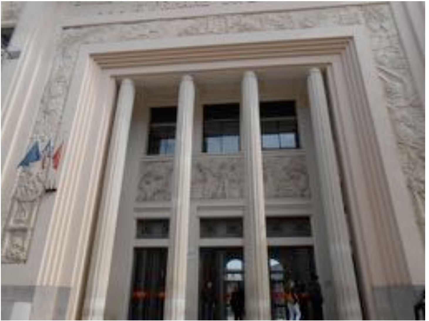
Détail façade avec les trois bas-reliefs sur la valeur du travail
