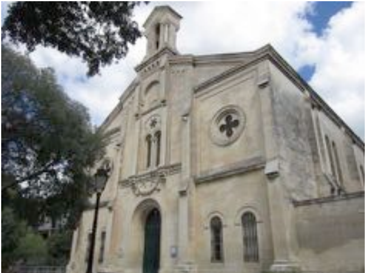
Vue d'ensemble de la façade sud, côté rue Hôtel-Dieu.
