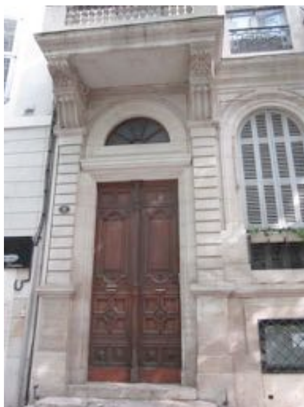
Entrée 2 place QUESTEL.
