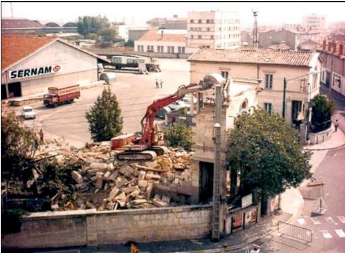
Démolition de la gare, terminal de la section Nîmes-Alès. Inaugurée en août 1840.
