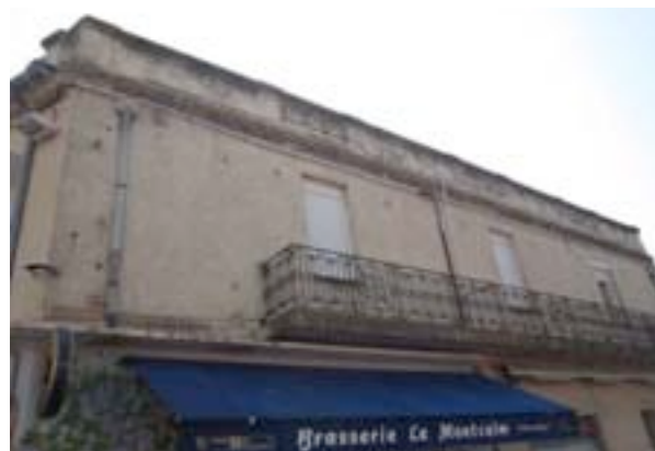
Façade sur la rue de Saint-Gilles.
