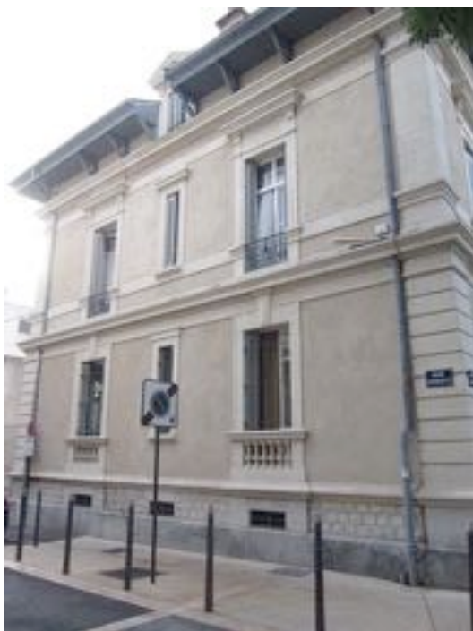
Façade sur rue Roumanille.
