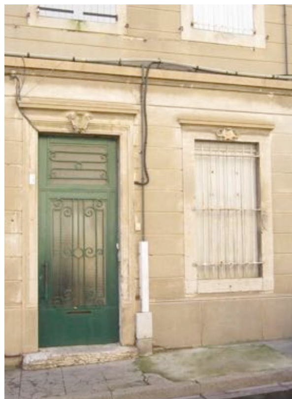
Entrée de l'immeuble.
