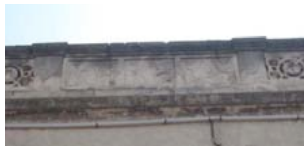
Mur acrotère, avec alternance de parties ajourées, et de parties pleines sculptées.
