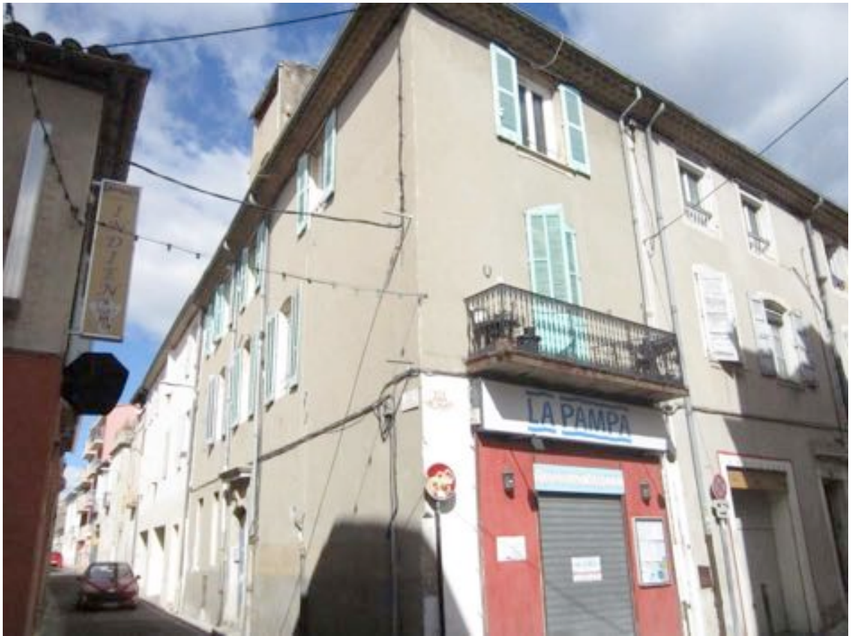
Façade rue Bigot / angle rue Porte de France.
