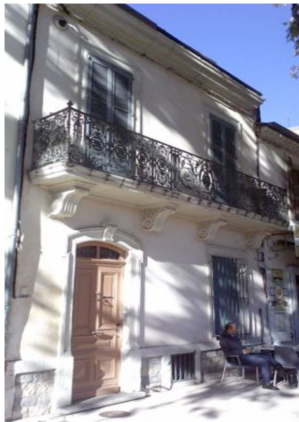
Vue d'ensemble de la façade.
