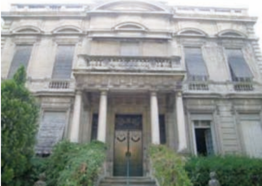
Façade sud, avec terrasse sur le parc :
