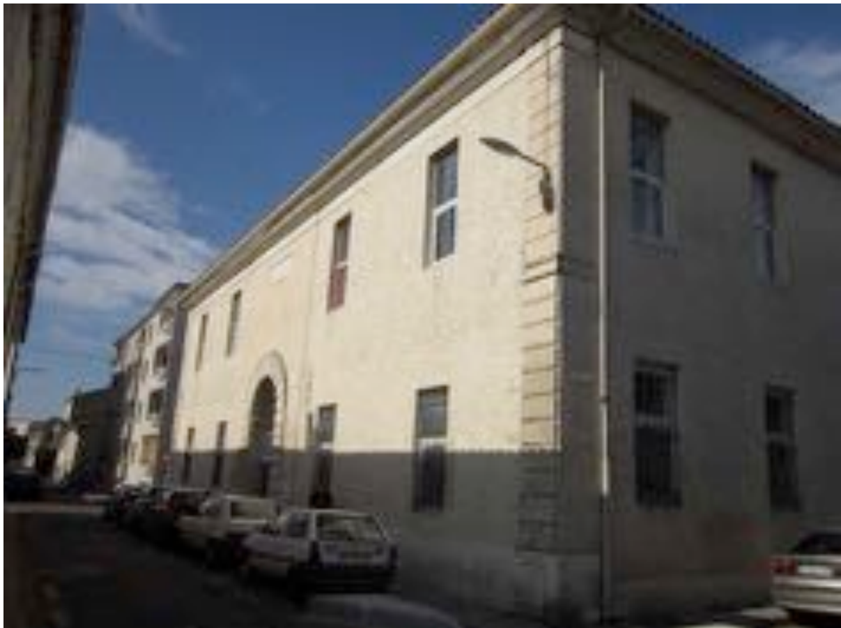
Façade sur rue de la Casernette, angle rue Vauban.
