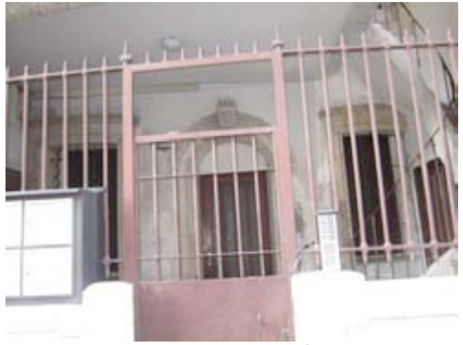
Ancienne façade au rez de chaussée, en recul d'environ deux mètres de la façade alignée sur rue, qui elle, est constituée d'une grille obturant une ouverture en arc surbaissé, avec une porte centrale, et deux allèges latérales.
