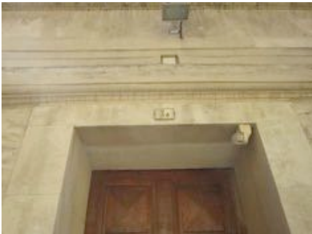
Entrée par la rue du Château FADAISE
