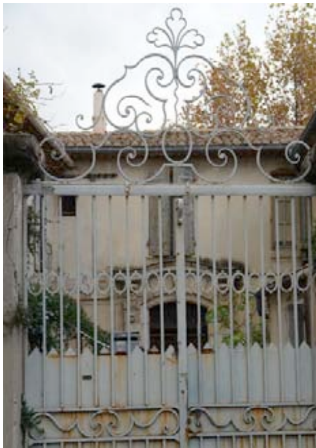
Le portail, sur l'ancienne voie domitienne :
