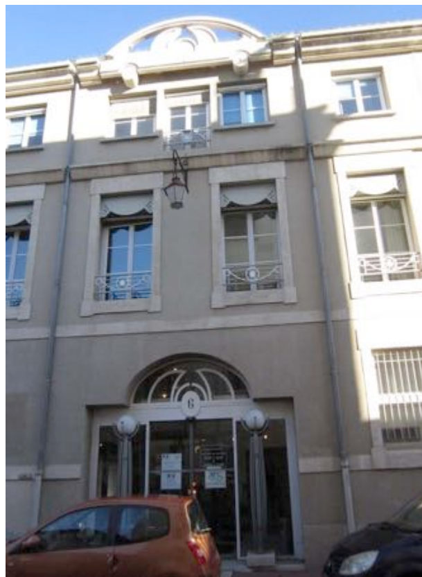
Travée centrale sur l'entrée.
