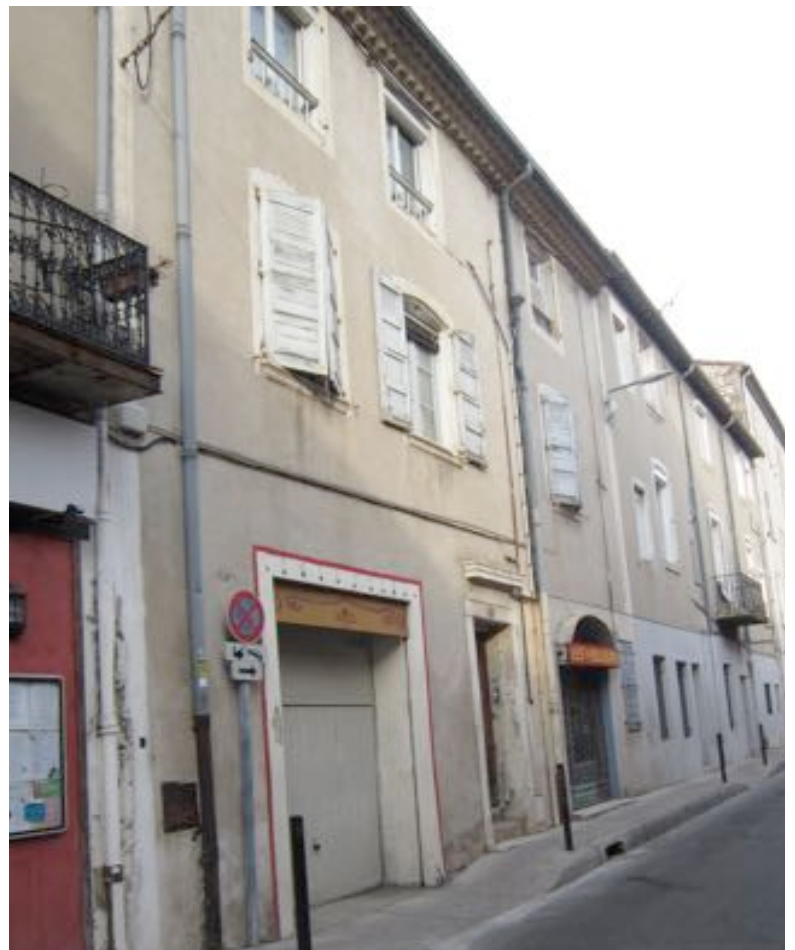
Façade Rue Porte de France.
