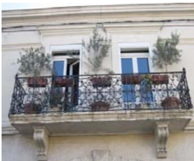
Détails sur balcon, garde-corps et corniche haute
