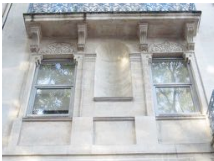
Détails de niche entre-deux fenêtres, au R+1, à gauche de l'entrée. Un ensemble identique est situé à droite de l'entrée.
