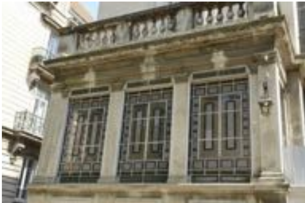
Au milieu : Véranda vitrée, sur « niveau noble », côté avenue Carnot.
