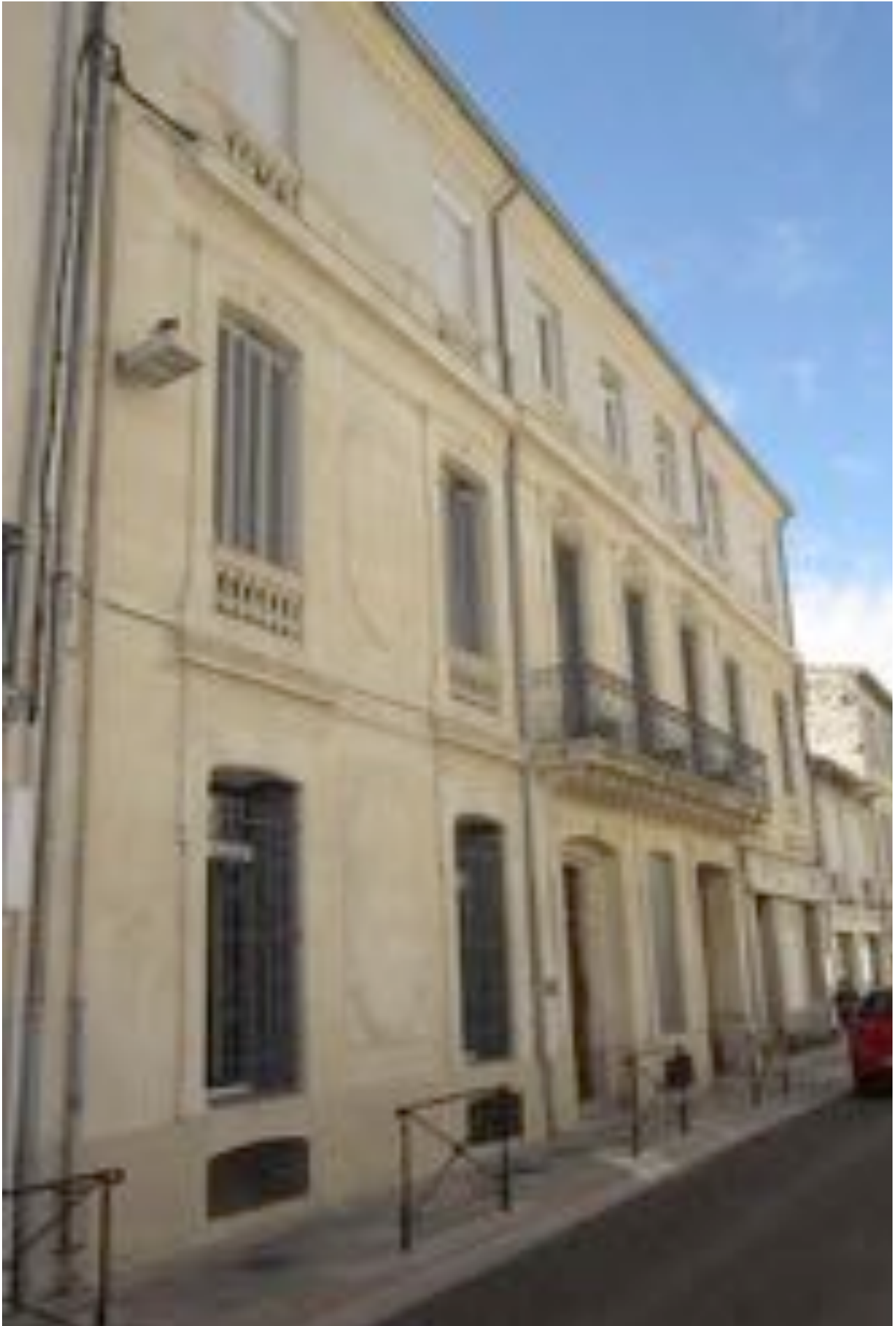
Une note dommageable : la non-homogénéité des menuiseries PVC du R+2. (Avec ou sans imposte, avec ou sans volets roulants)
