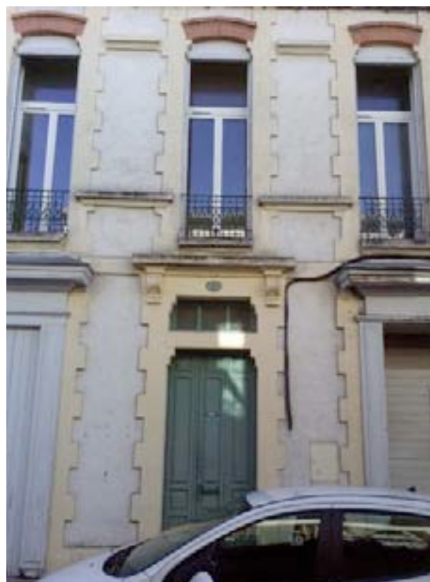
Entrée de l'immeuble.
