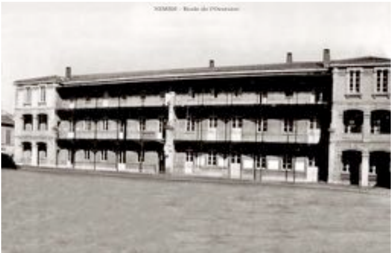
Le bâtiment d'origine, façade sud, sur rue Hôtel-Dieu.
