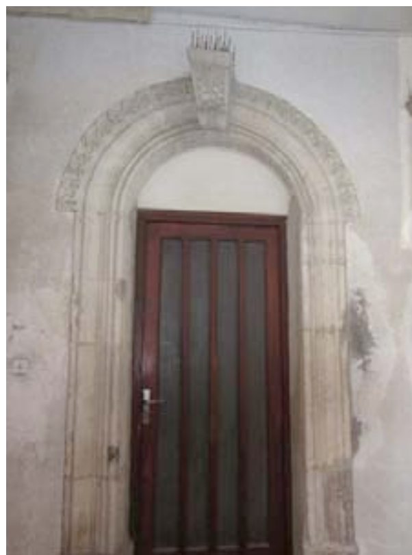
Porte d'entrée rez de chaussée.
