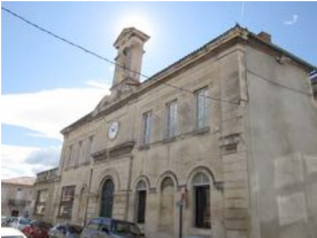
Façade sur rue BIGOT
