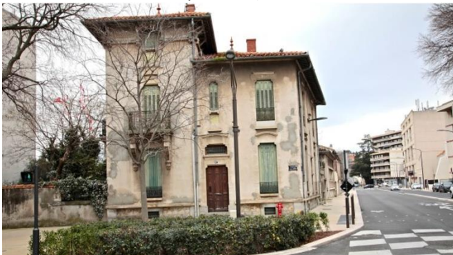
N° 56 ter (classée exceptionnel) maison art déco
